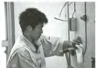
▲電気工事部門
